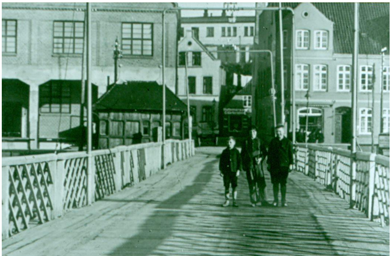
Broen på Alssiden med den nye margarinefabrik (BONA).
