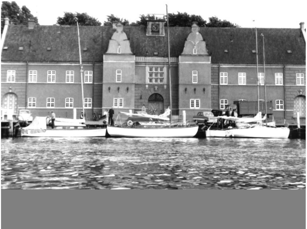
Toldkammer opført i 1925-26. Nedrevet i 1976.
