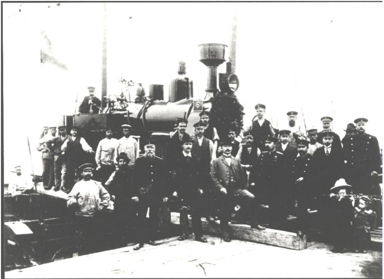
Lokomotiv over Allsund, alle lokomotiver blev transporteret over Allsund på en konstrueret tømmerflåde. Det første lokomotiv blev overført den 19. juni 1897. Overførslen var et meget stort arbejde, men nødvendigt, da den daværende pontonbro ikke kunne klare den store belastning.
