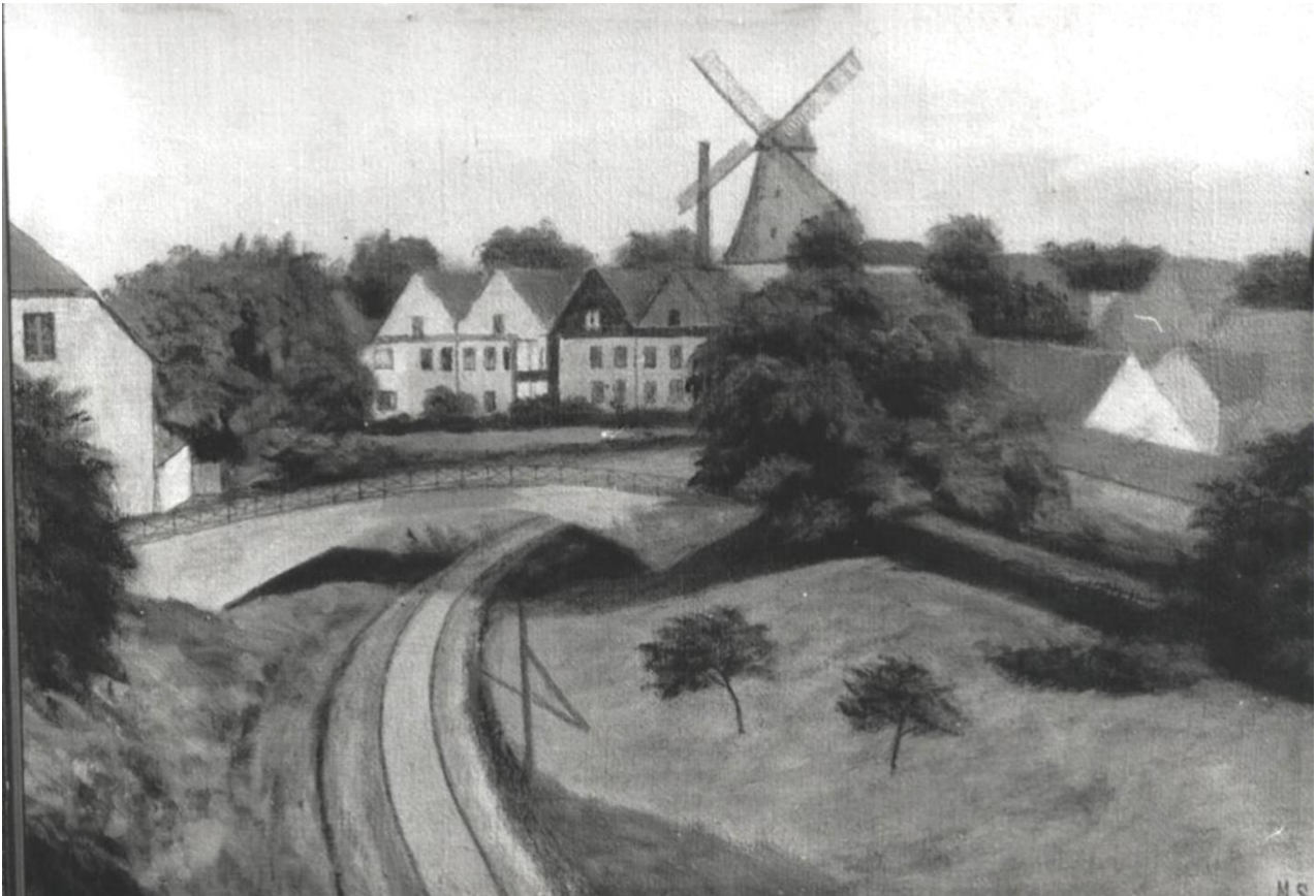
Viadukten under Rebslagergade, den afgravede jord blev brugt til opfyldning af "Andedammen", dere hvor banegården kom til at ligge.
