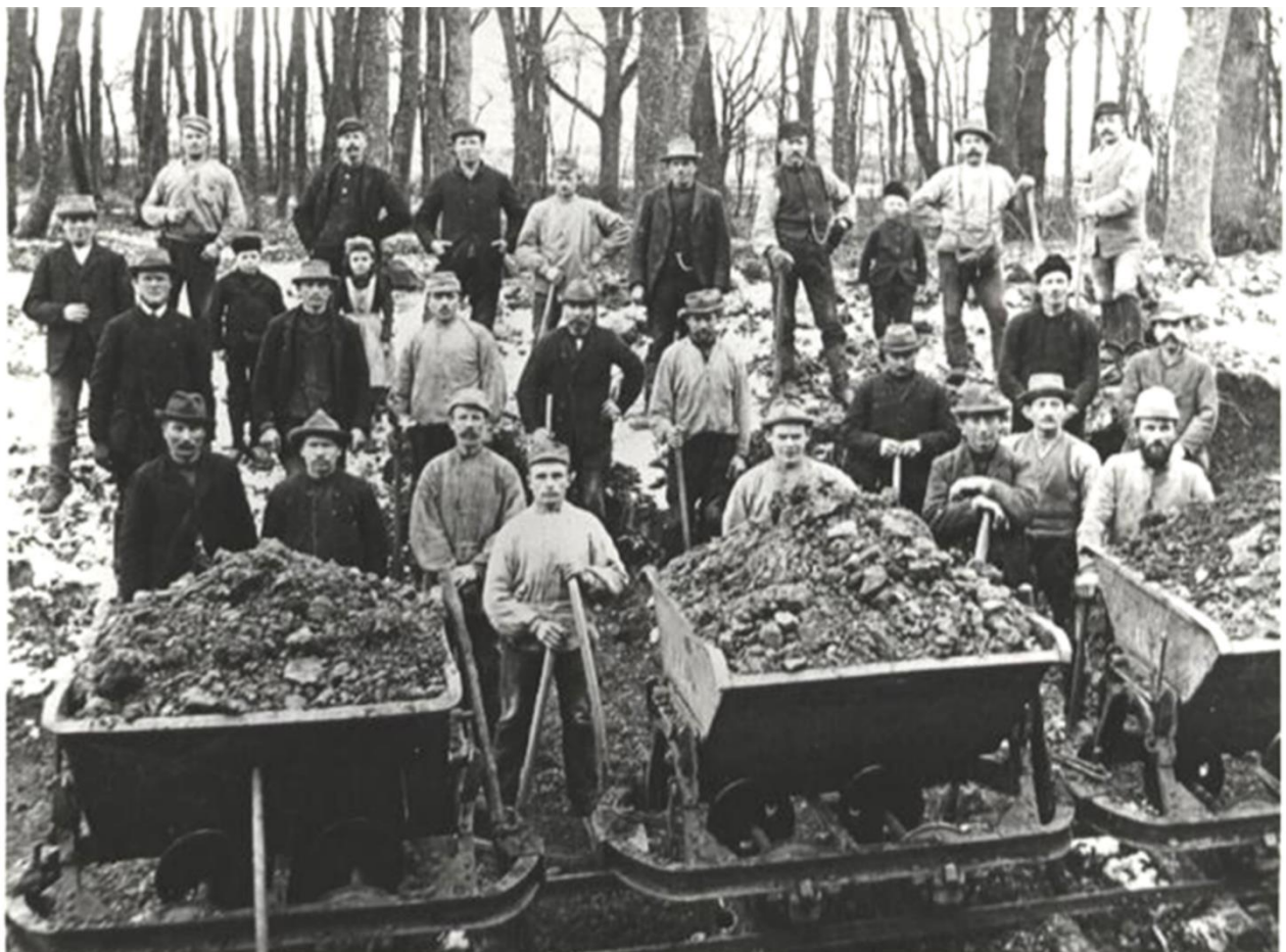
På strækningen mellem Guderup og Nordborg stødte man på vanskelige bundforhold i Karholm skov, og man blev nødt til at flytte omkring 30.000 m 3 mosejord eller læsse med spade ca 40.000 tipvogne
