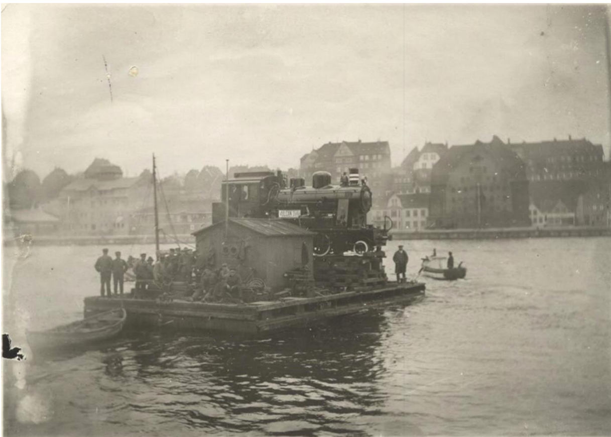
Lokomotiverne blev klodset op på en pram, som derefter blev slæbt over Sundet. Højden på opklodsningen skulle gerne passe med højden på den anden side.
