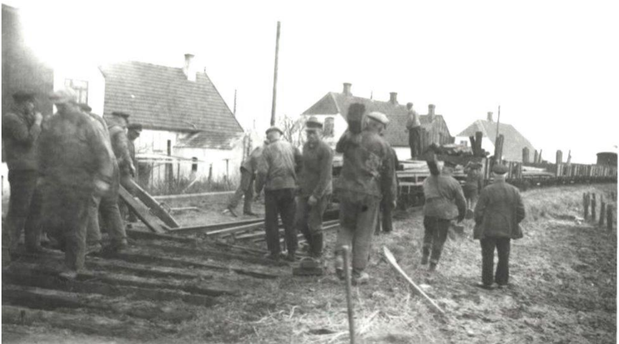
Optagning af skinner og sveller ved Svendstrup. En stor del af skinnerne blev solgt til Frederikshavn – Fjerritslev banen. En del af materiellet blev solgt til Tyskland og Polen. Et af lokomotiverne står den dag i dag på et museum i Polen. En del af de lukkede vogne blev solgt til private, som sommerhuse.
