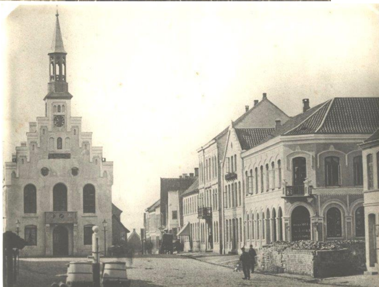
Rådhuset efter 1864. Rådhuset genopbygget i 1865 og blev indviet den 22. marts 1866.
