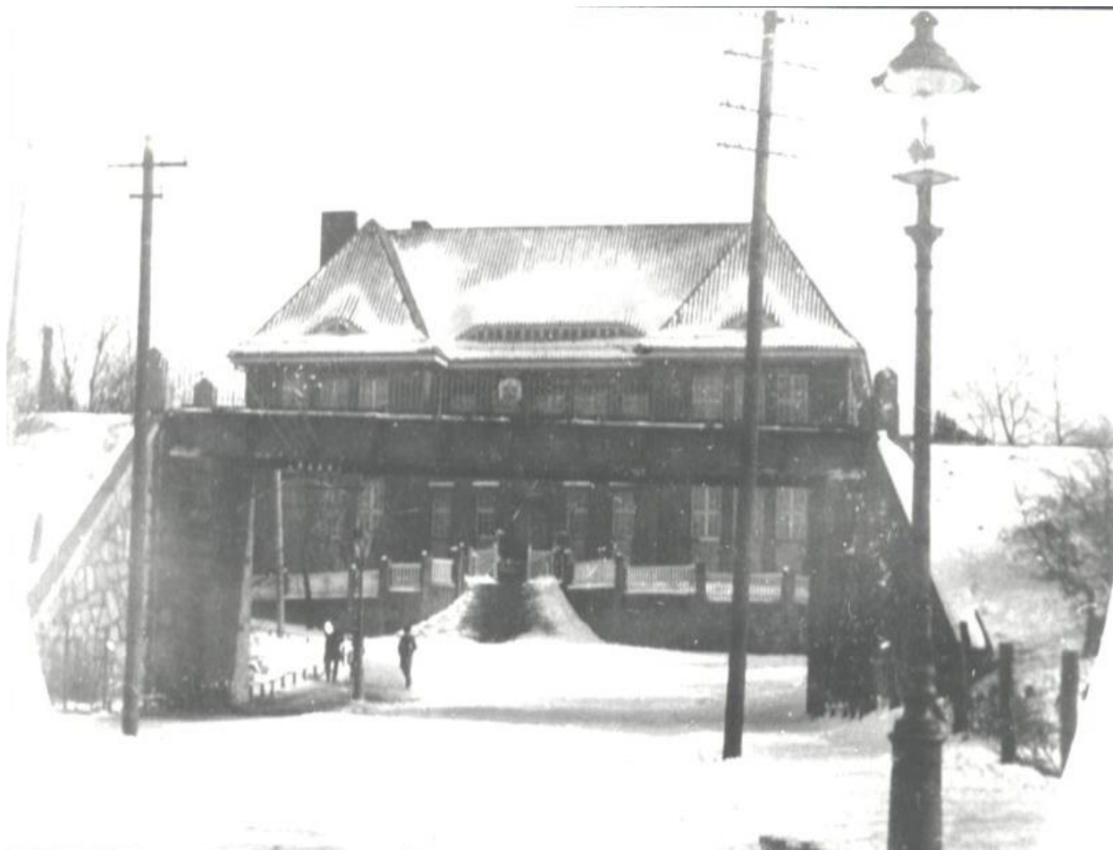
Broen over Østergade.
