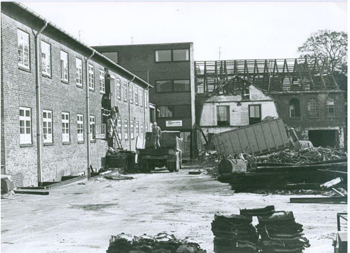
Løngang under nedrivning.
